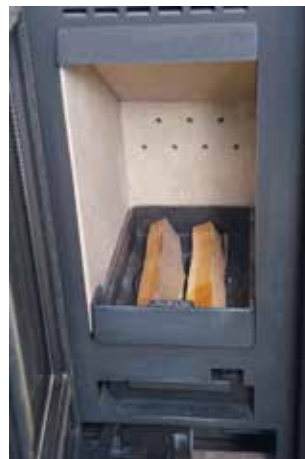
Auf den gesäuberten Rost bis zu vier Holzscheite kreuzweise aufstapeln. Unten größere, darauf kleiner Holzscheite.
