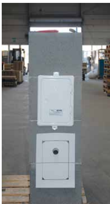
2. Schablone auf Siphonrohr aufstecken und an der Mantelsteinfuge ausrichten
