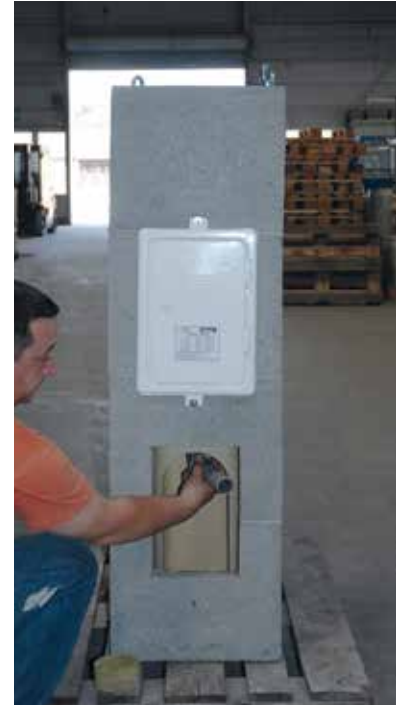
6. Nachdem die Steinstücke entfernt wurden, das Siphon entfernen.
