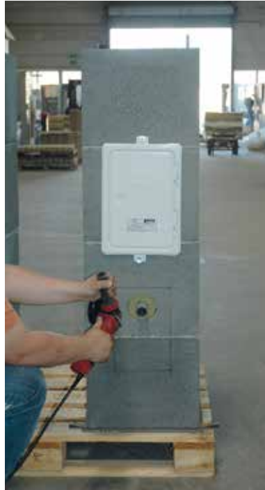
5. Mantelstein mit einem Trennschleifre entlang der angezeichneten Linien einschneiden
