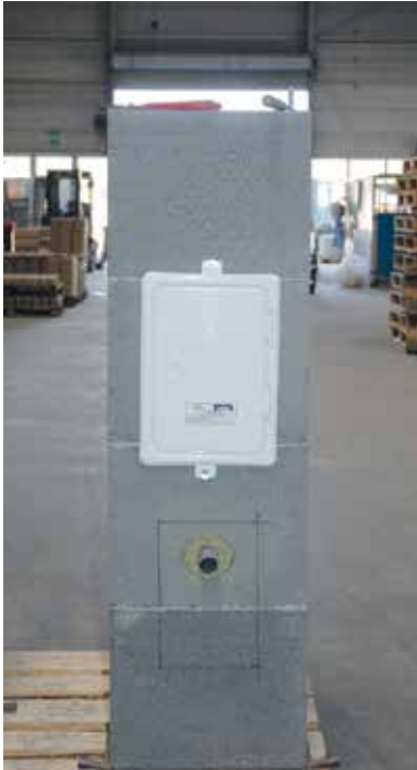
4. Angezeichnete Ecken verbinden = Ausschnitt
