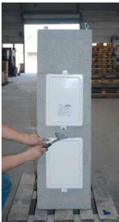
8. Türe einpassen und mit Nägeln fixieren.
