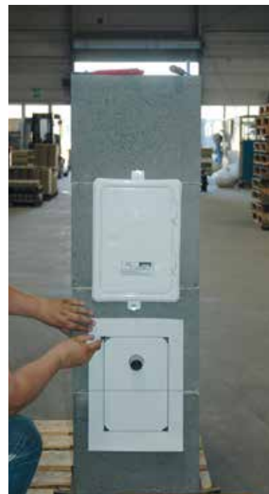
3. Ausschnitt-Ecken mit einem Stift kennzeichnen
