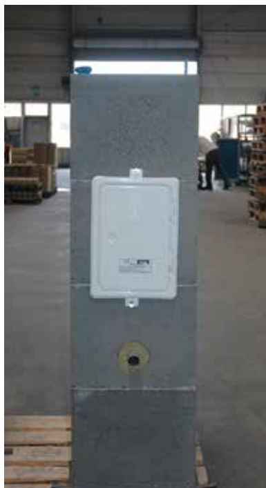
1. Fertigfuß aufstellen und ausrichten.
