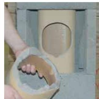
Fugenkitt bestreichen und an Öffnung einsetzen. Stutzen fixieren.
