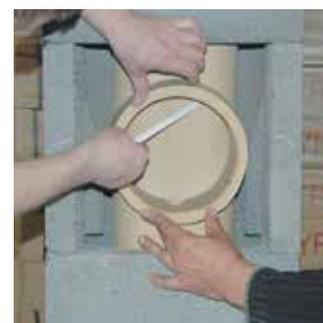
3. Rauchrohrstutzen am Rohr anhalten und Ausschnitt innen mit einem Bleistift anzeichnen.
