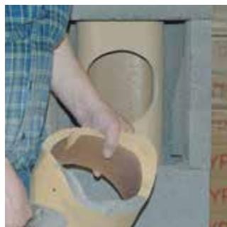
6. Säurekitt nach Anweisung anrühren. Rauchrohrstutzen an den Klebekanten mit
