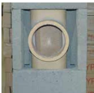
8. Klebestellen anhärten lassen (ca. 24 Stunden bei 20 °C), Die vollständige Aushärtung erfolgt nach 10 Tagen.
