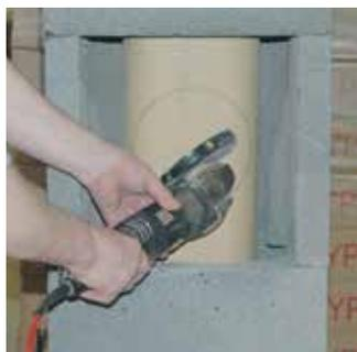
4. Angezeichneten Ausschnitt mit einem Winkelschleifer über Kreuz an- und heraus-schneiden.
