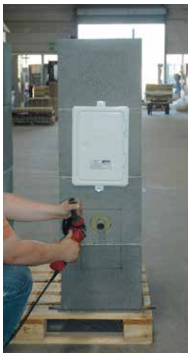
5. Mantelstein mit einem Trennschleifer entlang der angezeichneten Linien einschneiden
