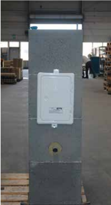
1. Fertigfuß aufstellen und ausrichten.
