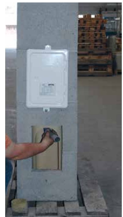
6. Nachdem die Steinstücke entfernt wurden, das HT-Rohr entfernen.
